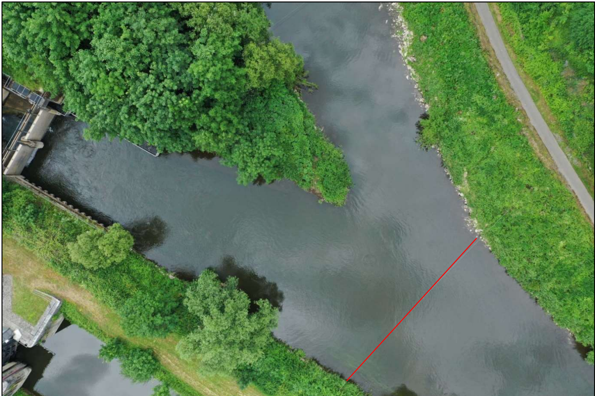
Abb. 19: Zusammenfluss der Ausleitungsstrecke mit Turbinenauslaufkanal bei 2 \text{ m}^3/\text{s} im Querprofil 8.
