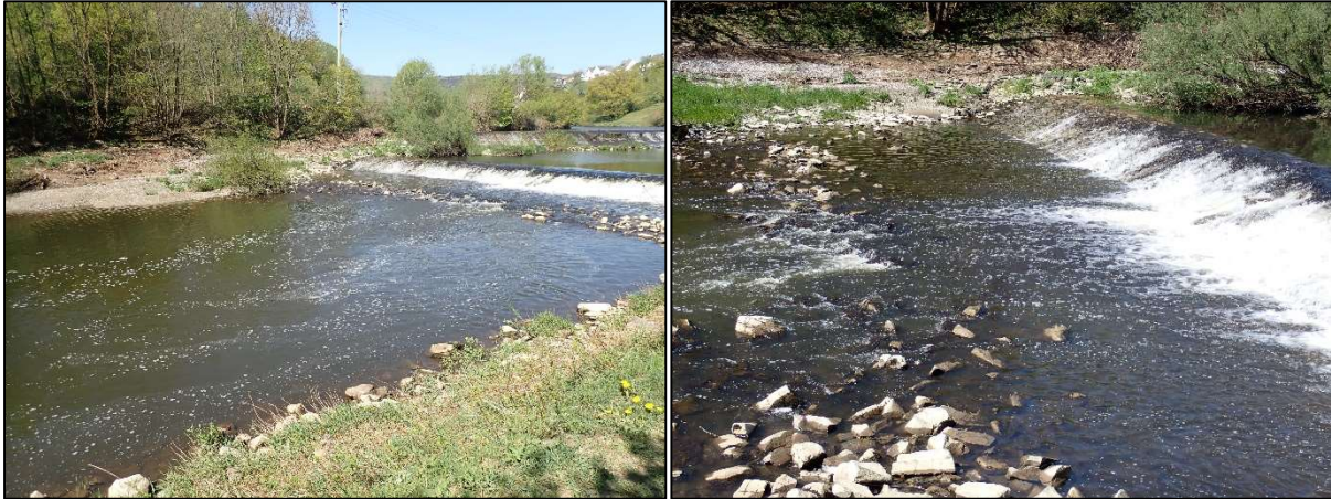
Abb. 4: Ausleitungsstrecke unterhalb des unteren Wehrs. Links: Übersicht mit Eindruck der Kiesbank im Gleithang. Rechts: Flach überströmter Bereich direkt unterhalb des Wehres.
