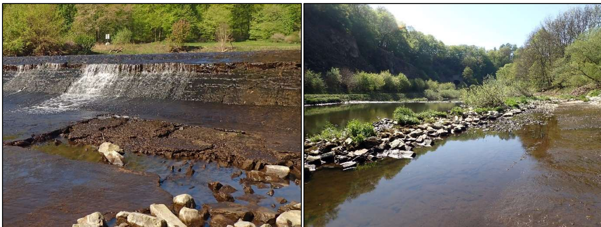
Abb. 12: Strukturen im Bereich des oberen Abschnitts der Ausleitungsstrecke (zwischen den Wehren). Links: aufgebrochene Sohlbefestigung. Rechts: teilweise bewachsener Steinriegel mit Kiesanlandungen.
