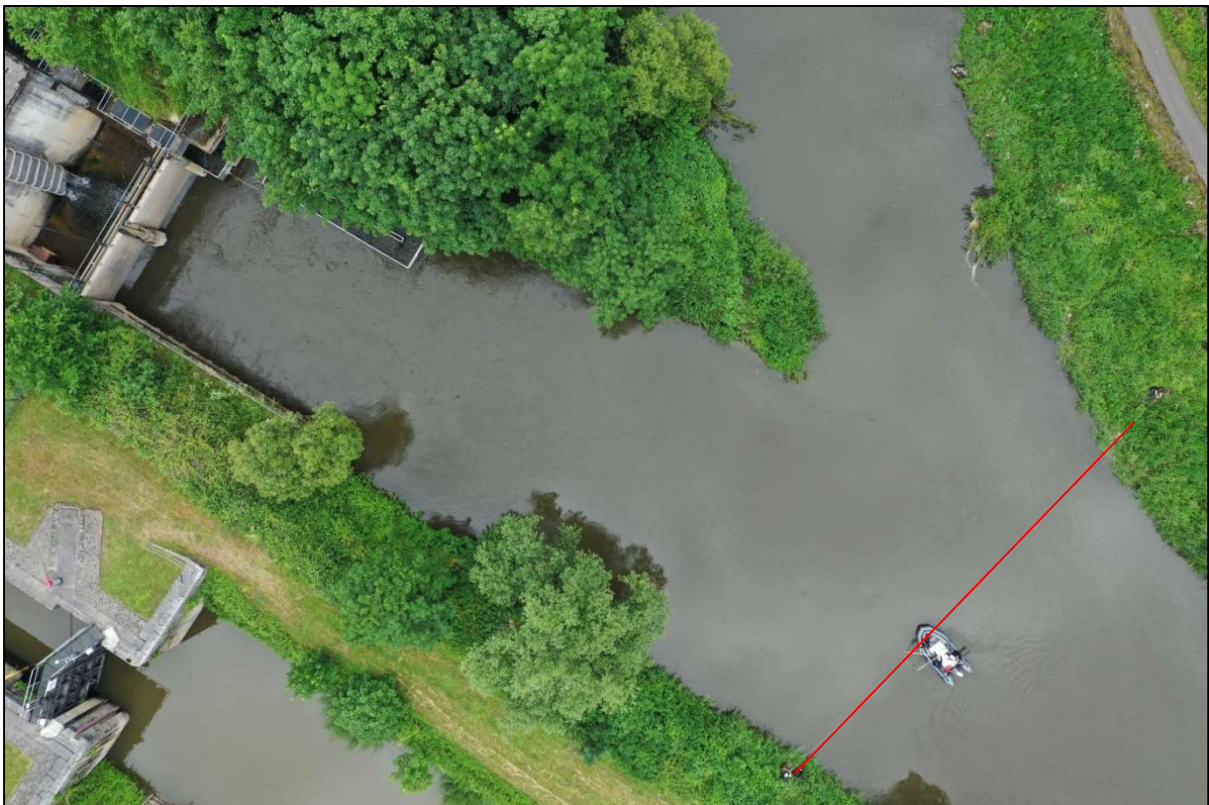
Abb. 23: Zusammenfluss der Ausleitungsstrecke mit Turbinenauslaufkanal bei 4 \text{ m}^3/\text{s} im Querprofil 8.
