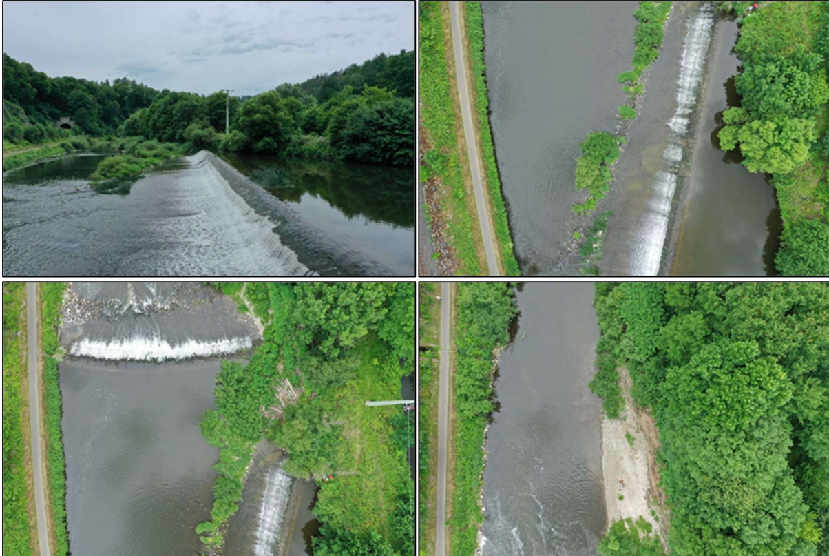
Abb. 16: Oberes und unteres Wehr bei 2 m 3 /s Abfluss vollkommen überströmt, an rechter Uferseite Bucht (an Kiesbank) mit Rückströmung.
