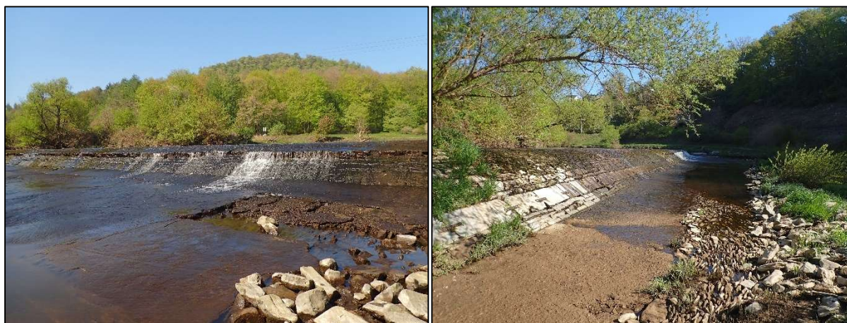
Abb. 9: Ungleichmäßige Überströmung des Ausleitungswehrs der WKA Kirschhofen bei geringem Wehrüberfall. Links: deutlich identifizierbarer Tiefpunkt. Rechts: Unterläufigkeit erkennbar (Vordergrund).
