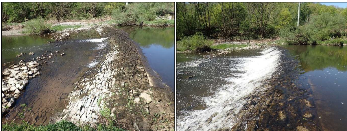
Abb. 7: Abflusssituationen am unteren Wehr in der Ausleitungsstrecke während einer Oberwasserschwankung am 21.04.2021. Links: 12:00 h. Rechts: 12:59 h.
