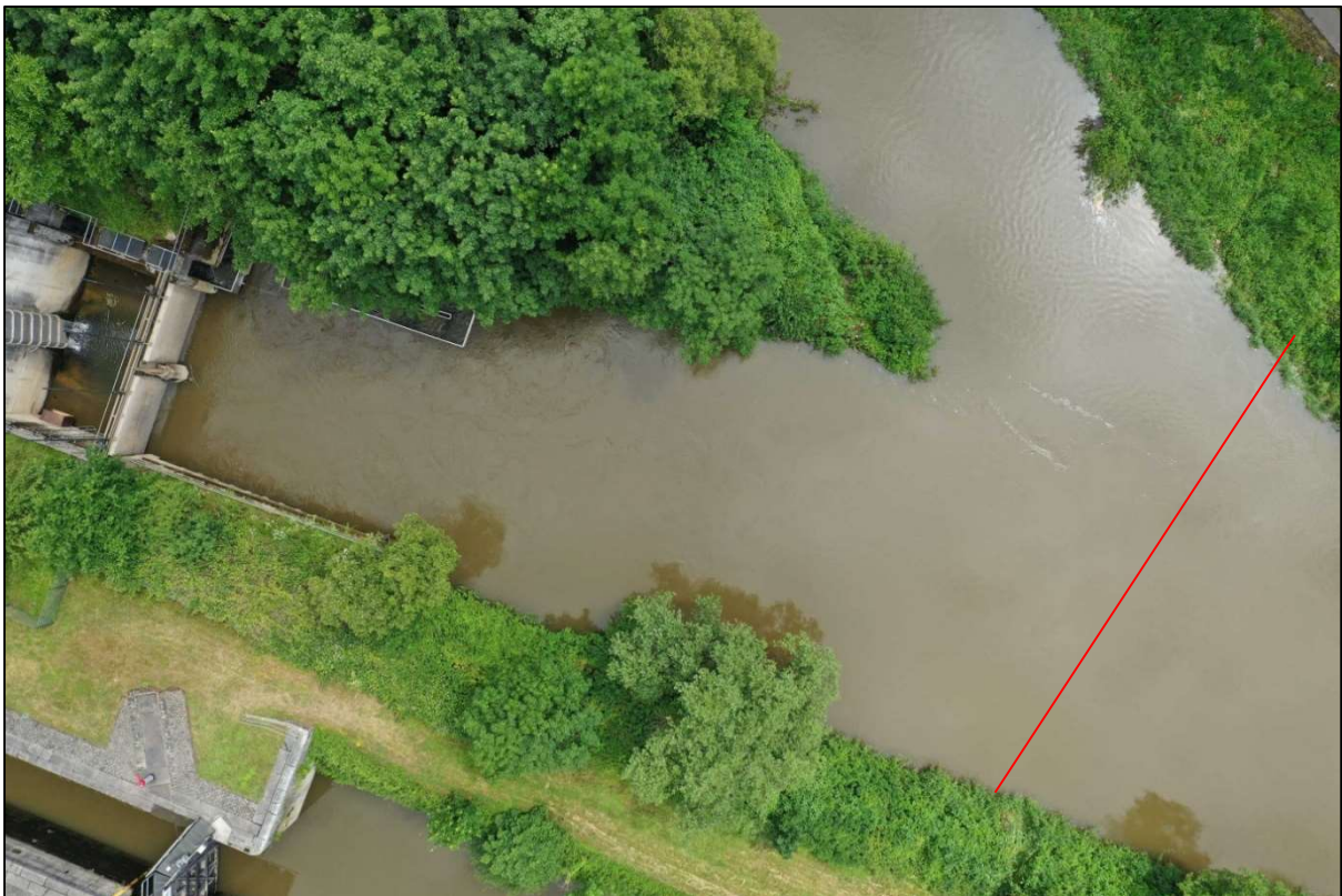
Abb. 27: Zusammenfluss der Ausleitungsstrecke mit Turbinenauslaufkanal bei 6 m 3 /s im Querprofil 8.
