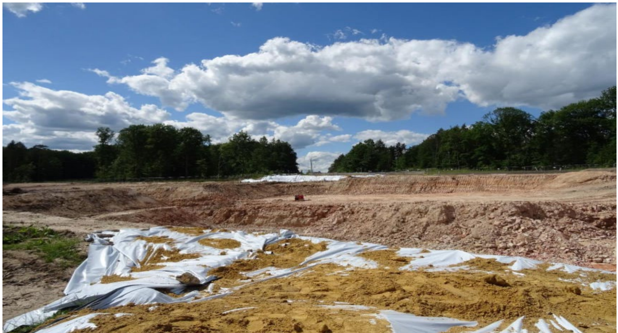
Abbildung 7: Blick in die Baugrube entlang der ausgebauten Artilleriestraße von Ost nach West. Die Anschlussstellen an die noch bestehende Artilleriestraße sind mit Folie abgedeckt. © RP Gießen
