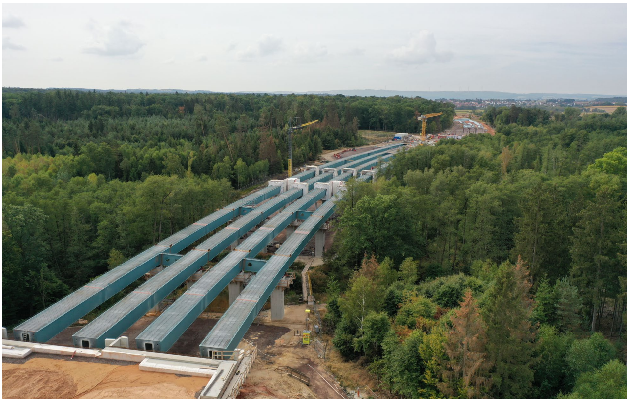
Abbildung 1: Überblick über die Autobahn-Baustelle bei Stadtallendorf.
