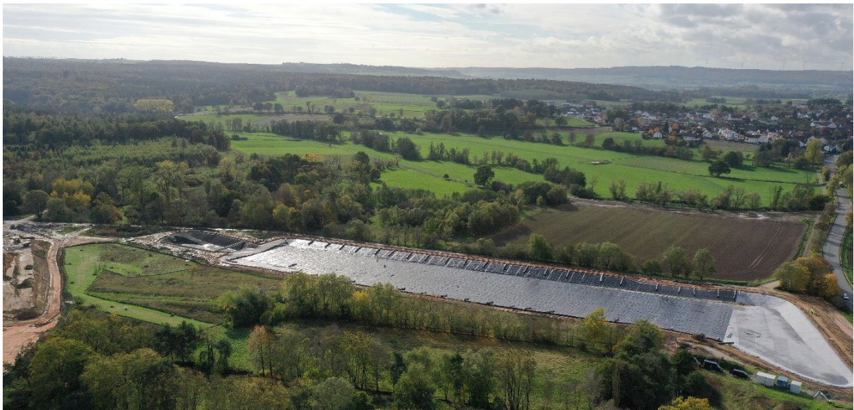
Abbildung 4: Das RRB UJ befindet sich nördlich von Niederklein, südlich der L 3290 und westlich zur geplanten Autobahn innerhalb der Schutzzone II des Wasserschutzgebietes. Mit 12.430 Kubikmetern Rückhaltevolumen ist das RRB UJ das größte planfestgestellte RRB und soll im Frühjahr 2023 fertig gestellt werden (Aufnahme vom 24.10.2022).
