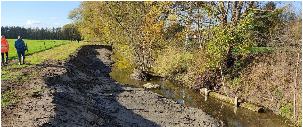
Abbildung 8: Neue Berme mit Totholz im Lückenbach.
