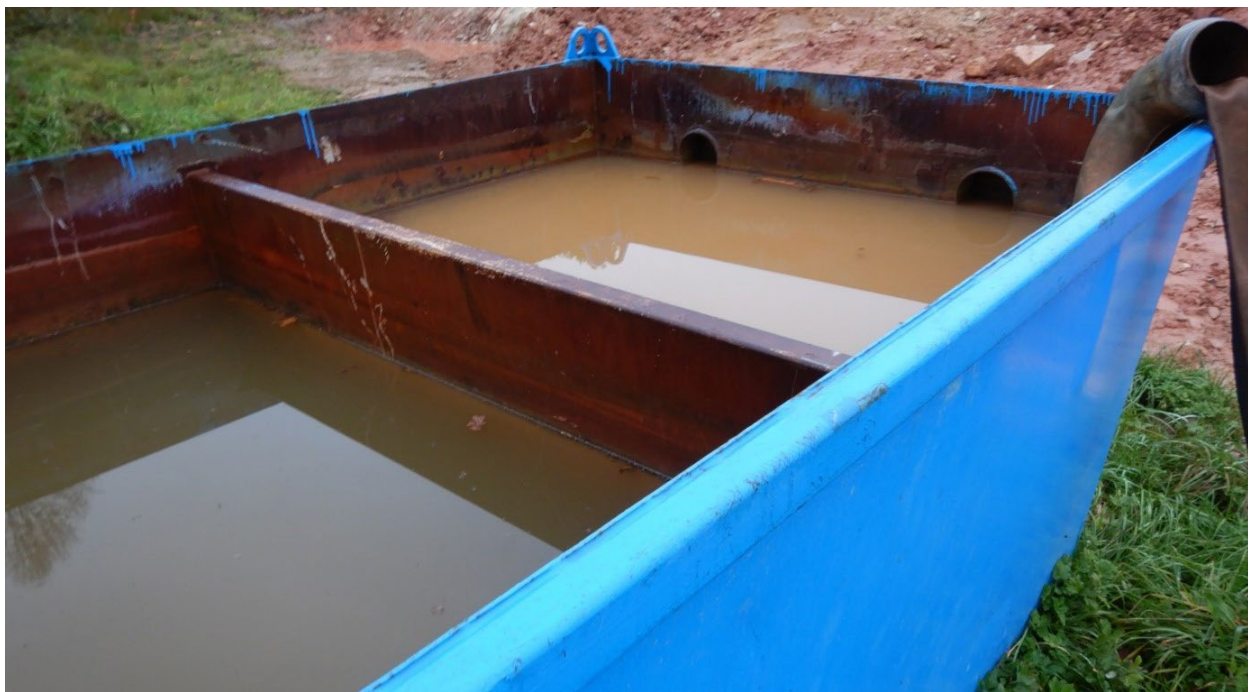
Abbildung 5: Mobiler Absetzcontainer. Nachdem sich die Sedimente abgesetzt haben, wird die Klarphase gedrosselt in ein Gewässer eingeleitet (Aufnahme vom 03.11.2021). © RP Gießen
