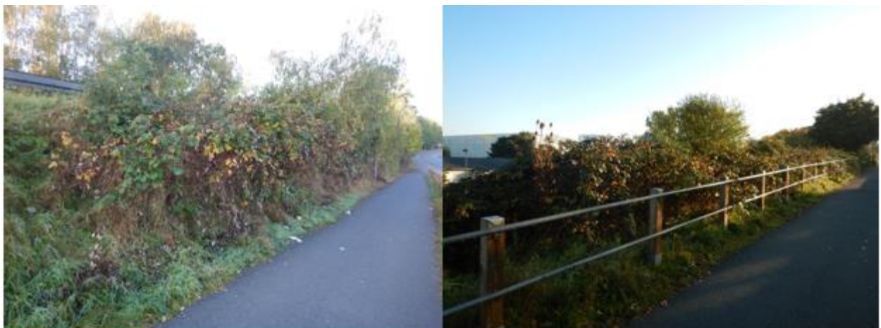
Abbildung 2: Böschung der Heuchelheimer Straße auf der nördlichen Seite.
