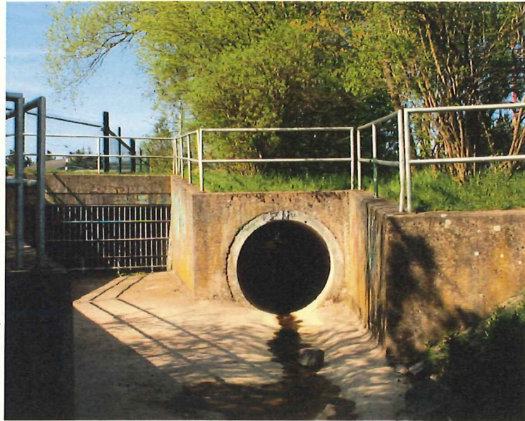
Abbildung 2: Münchbach unterwasserseitig der B 454
