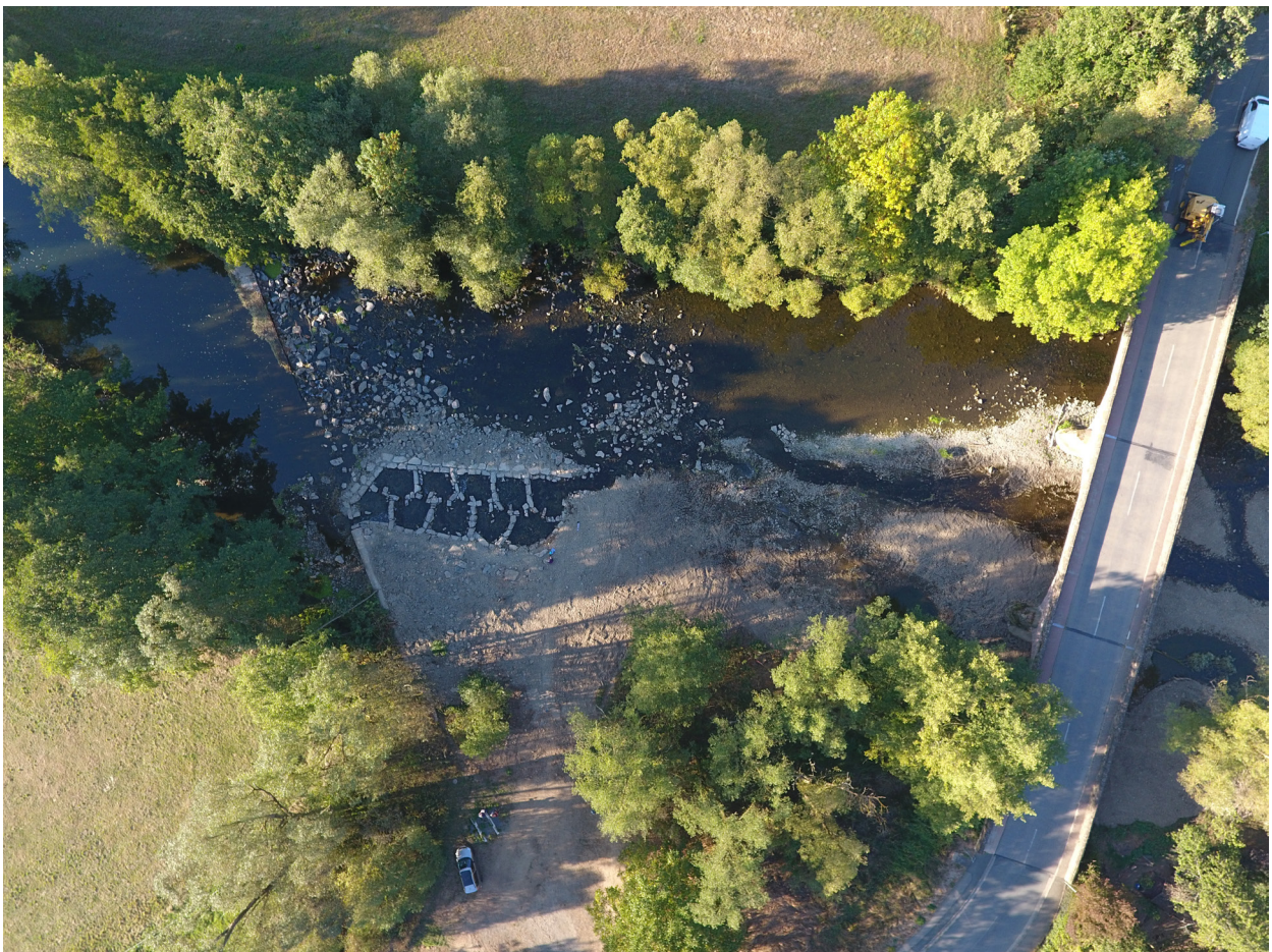
Abbildung 8: Wehr bei Kernbach, Riegelfischpass. © Peter Groß
