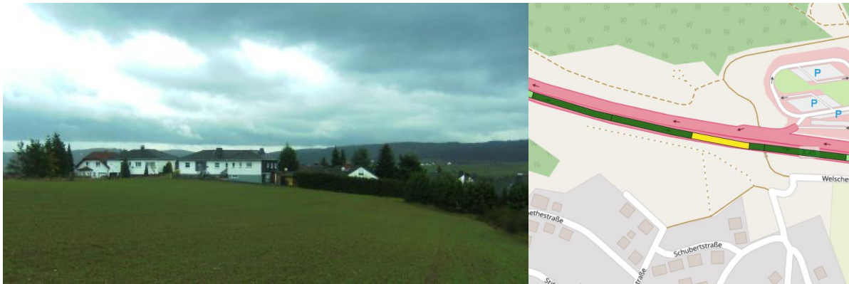
Abbildung 40: Bebauung entlang der A 45 im Ortsteil Katzenfurt (links) und Visualisierung des Lärmkonfliktpunkts A 45 im Nachtzeitraum durch normierte Lärmkennziffernbänder (rechts). 9091
