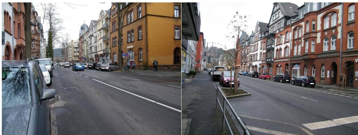
Abbildung 91: Charakteristische Bebauung in der Biegenstraße (links) und der Deutschhausstraße (rechts). 181
