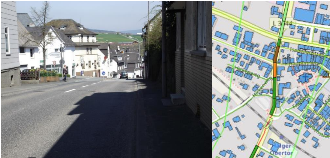
Abbildung 44: Bebauung entlang der L 3044 in der Kernstadt (links) Visualisierung des Lärmkonfliktpunkts im Nachtzeitraum durch normierte Lärmkennziffernbänder (rechts). 9697
