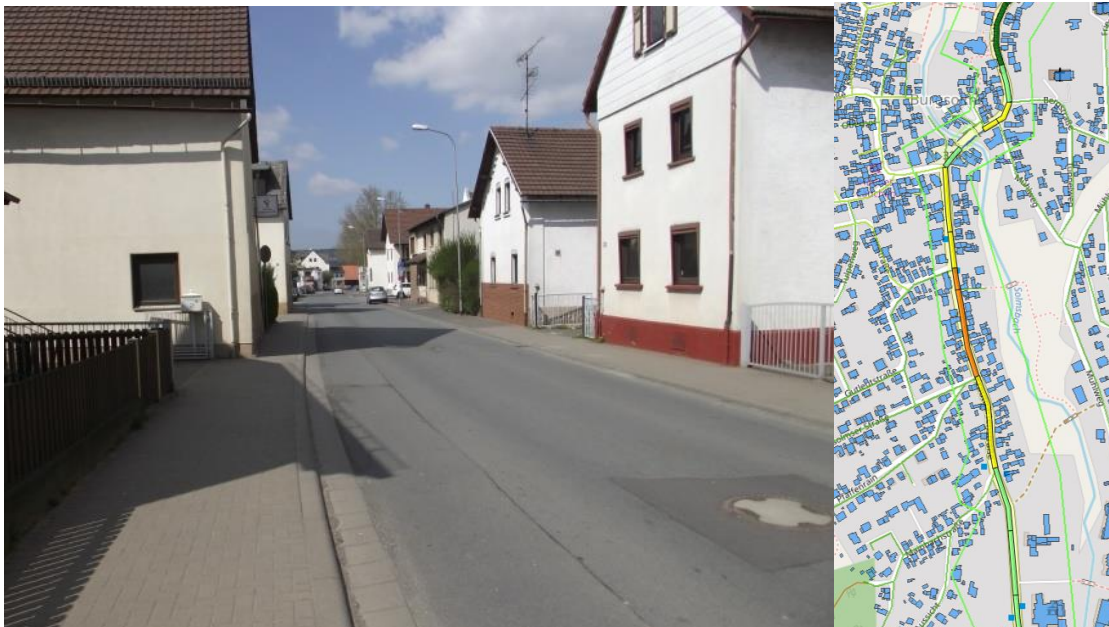
Abbildung 53: Bebauung entlang der L 3283 in Burgsolms (links) Visualisierung des Lärmkonfliktpunkts im Nachtzeitraum durch normierte Lärmkennziffernbänder (rechts). 110111
