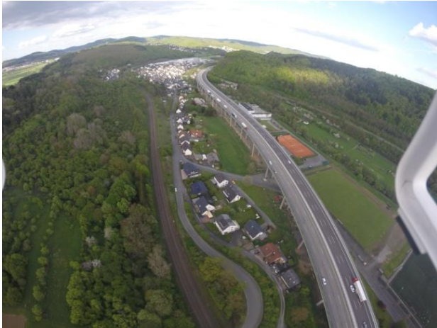
Abbildung 42: Talbrücke Sechshelden mit unterliegender Wohnbebauung. 94
