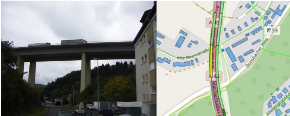
Abbildung 38: Bebauung an der A 45 Dillenburg, Höhe Erlenweg (links) und Visualisierung des Lärmkonfliktpunktes durch normierte Lärmkennzifferbänder im Nachtzeitraum (rechts). 86,87
