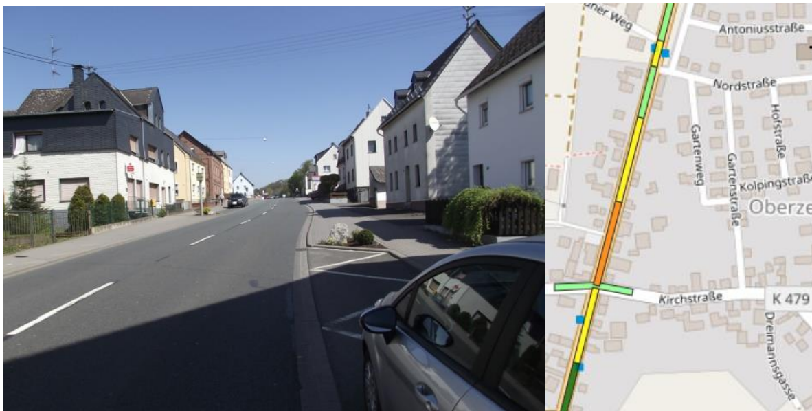
Abbildung 73: Bebauung entlang der B 54 in Oberzeuzheim (links) und Visualisierung des Lärmkonfliktpunktes im Nachtzeitraum durch normierte farbige Lärmkennziffernbänder (rechts). 150151
