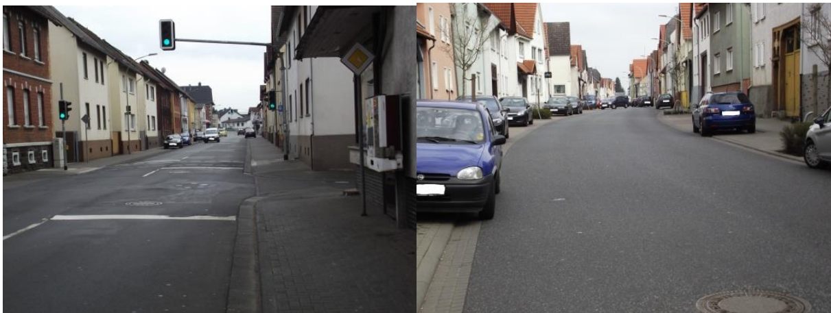
Abbildung 28: Bebauung an der L 3129 in der Ortsdurchfahrt von Großen-Linden (links) und Leihgestern (rechts). 68
