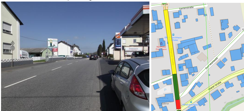
Abbildung 68: Bebauung entlang der B 54 in Dorchheim (links) und Visualisierung des Lärmkonfliktpunkts im Nachtzeitraum durch normierte, farbige Lärmkennziffernbänder (rechts). 138139
