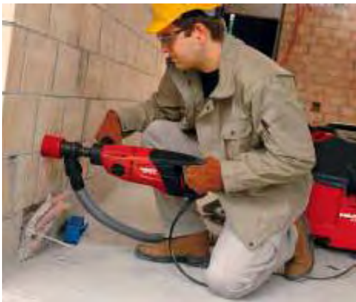
Bild 2: Diamantbohren, Dosen senken
