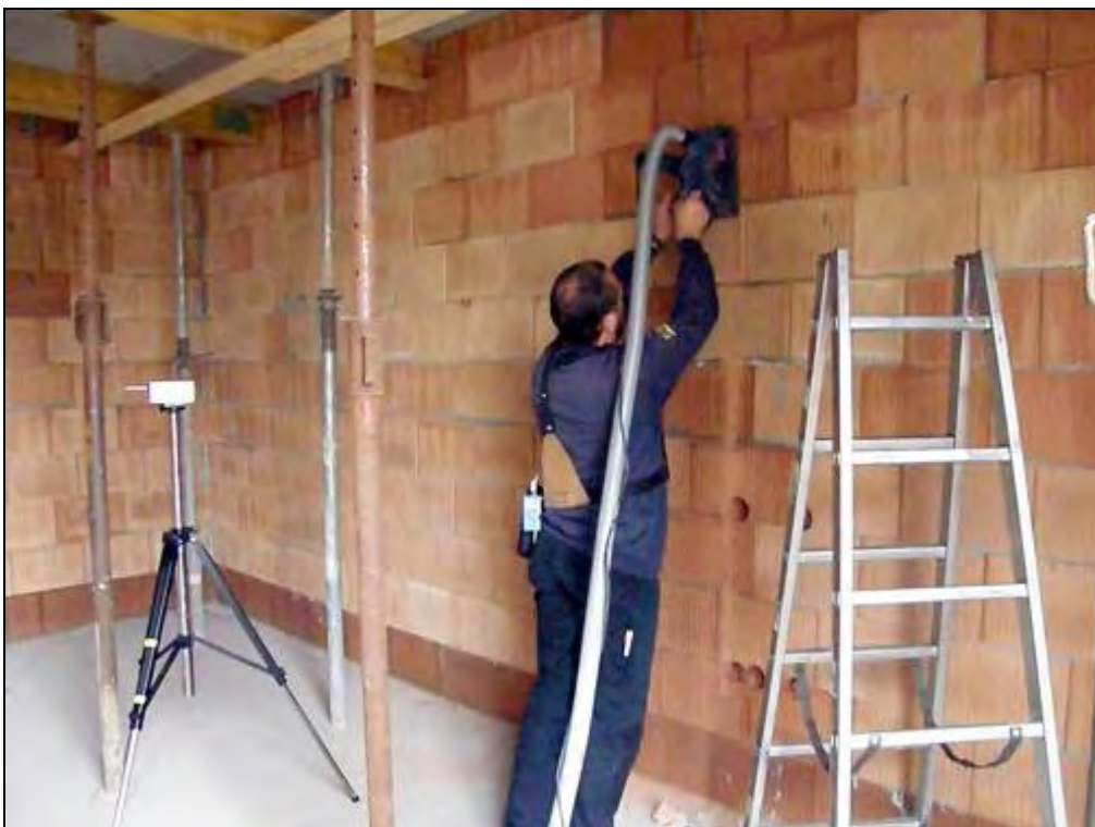
Bild 6: Personengetragene und stationäre Messung beim Mauernutfräsen in einem Rohbau
