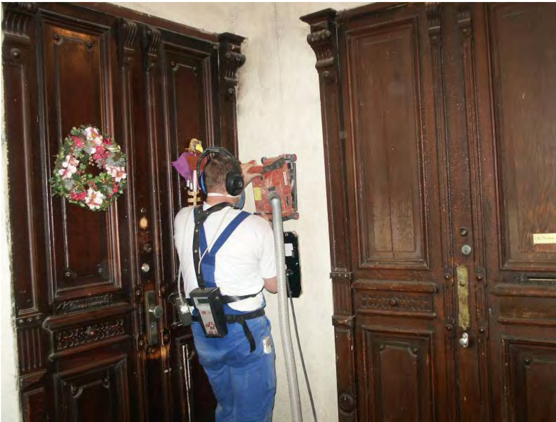
Bild 8: Fräsarbeiten in einem Altbautreppenhaus
