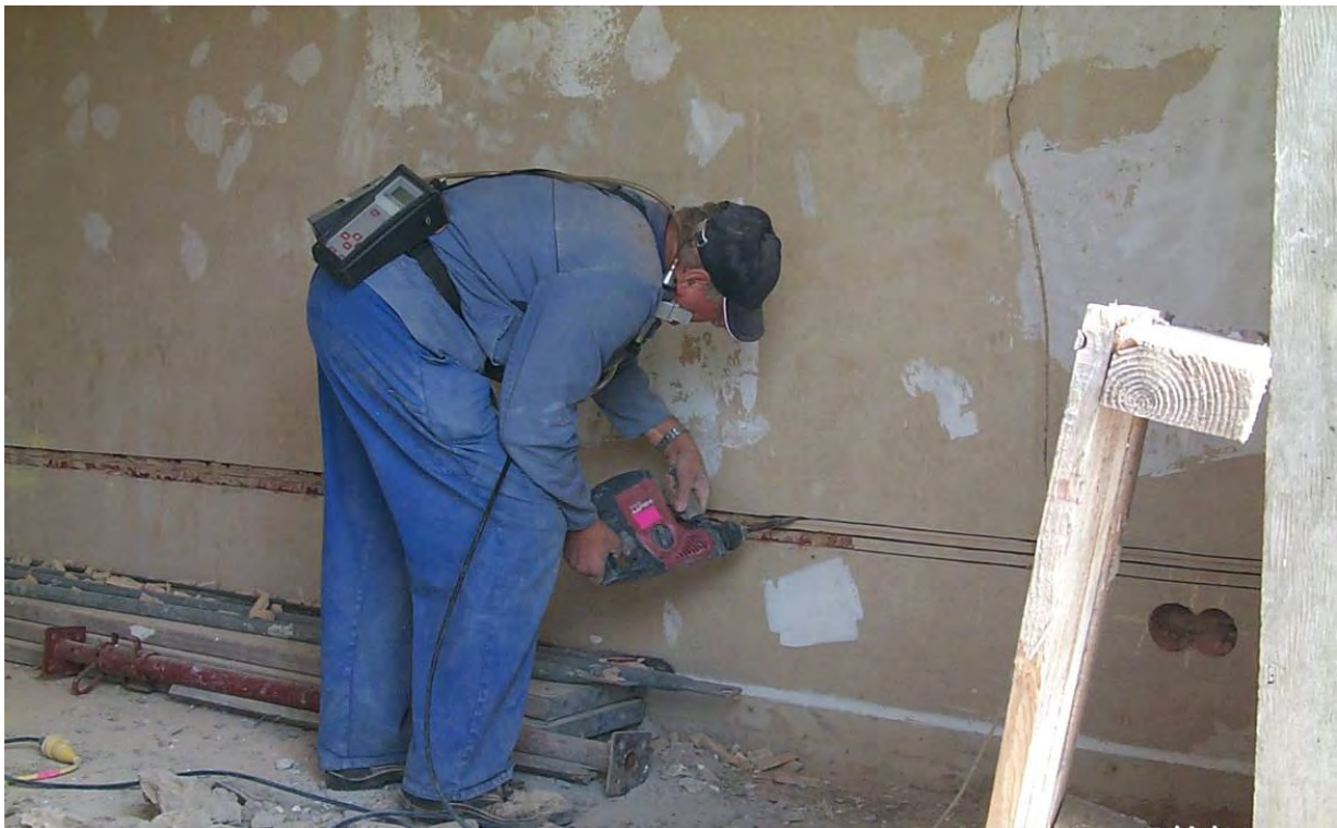
Bild 9: Ausbrechen der Stege mit Kombihammer
